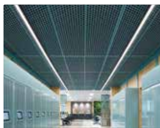
REBAIXAMENTO DE TETO
