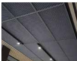
REBAIXAMENTO DE TETO
